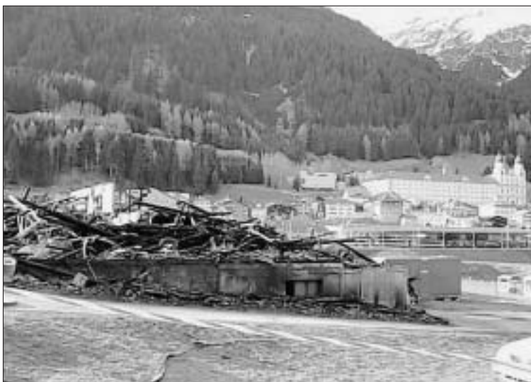
Das traurige Bild des bis auf die Grundmauern zerstörten Klosterhofs Salaplauna in Disentis. (Foto Larissa M. Bieler)
