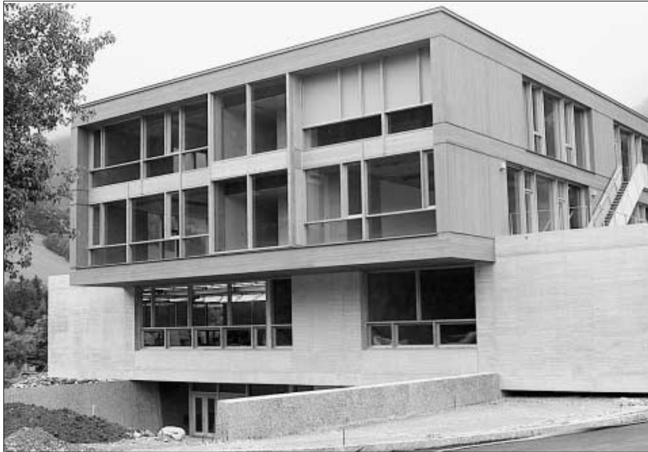
Die Jungunternehmer können im September kommen: Derzeit wird am Gebäude, welches das Innovations- und Gründerzentrum Innozet in Grüşch beherbergen wird, noch kräftig gearbeitet.
